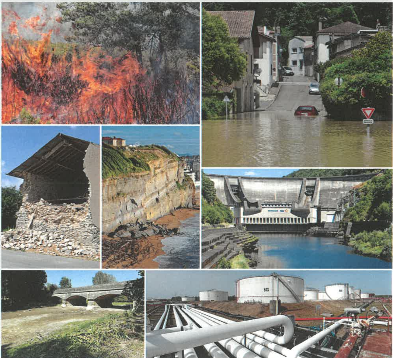
Photos : © Thierry Degen / DREAL Nouvelle-Aquitaine
